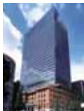
● 日本工業倶楽部会館・ 三菱UFJ信託銀行本店ビル 2003年2月竣工
