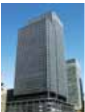
● 新丸の内ビル 2007年4月竣工
