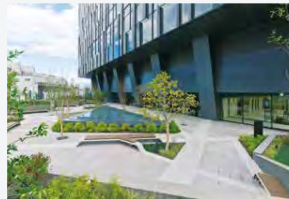
大名古屋ビルヂング
