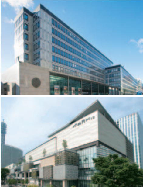
上／1 Victoria Street 下／MARK IS みなとみらい
