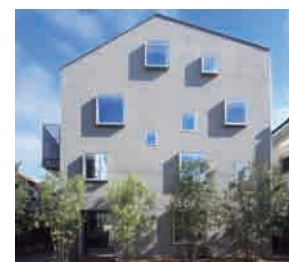
ParkHouse 吉祥寺 OIKOS 是国土交通省“住宅建筑物省CO 2 推进模范事业”的共9户环保型集团住宅(生态公寓)。通过导入外断热工法、地板下暗箱型空调系统等省CO 2 技术，在消减CO 2 和能源消耗的同时实现了新的舒适性
