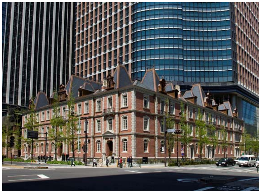
■ 三菱一号館<全景>
