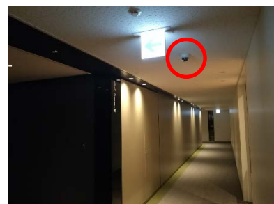
2階 [B] エレベータホール前廊下
