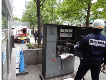
燃料輸送車両が給油を行う様子
