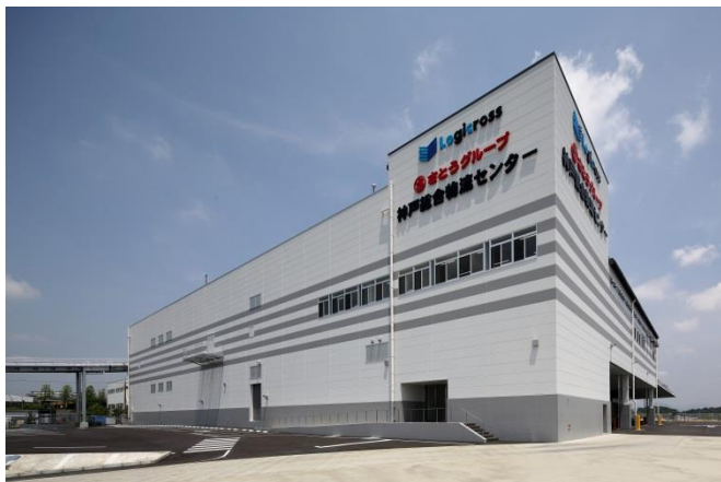
ロジクロス神戸三田 外観
