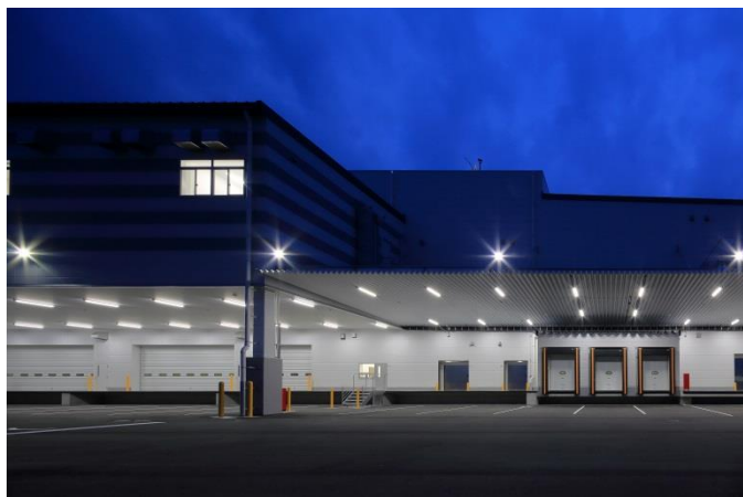
東側トラックバース
