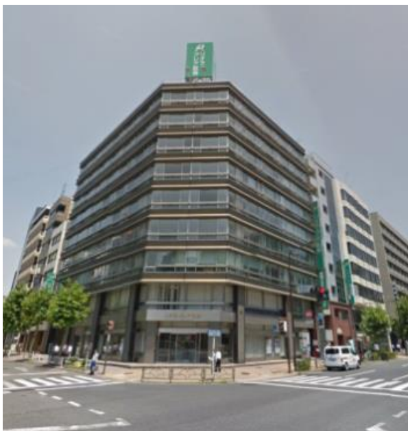
【茅場町共同ビル 外観写真】
