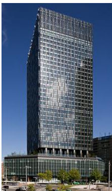
大名古屋ビルヂング
