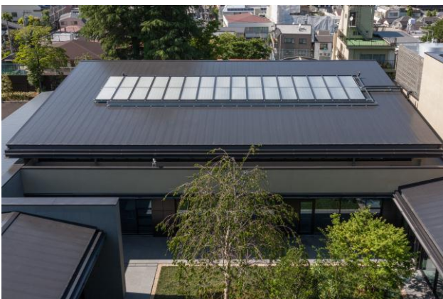
< 太陽光集熱による給湯システム >
