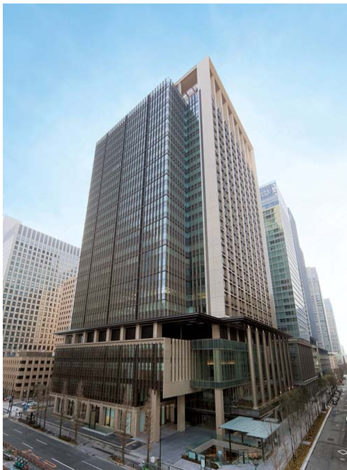
<外観全景（北西より）>
