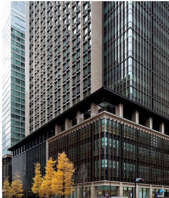
<外観低層部（北東より）>
